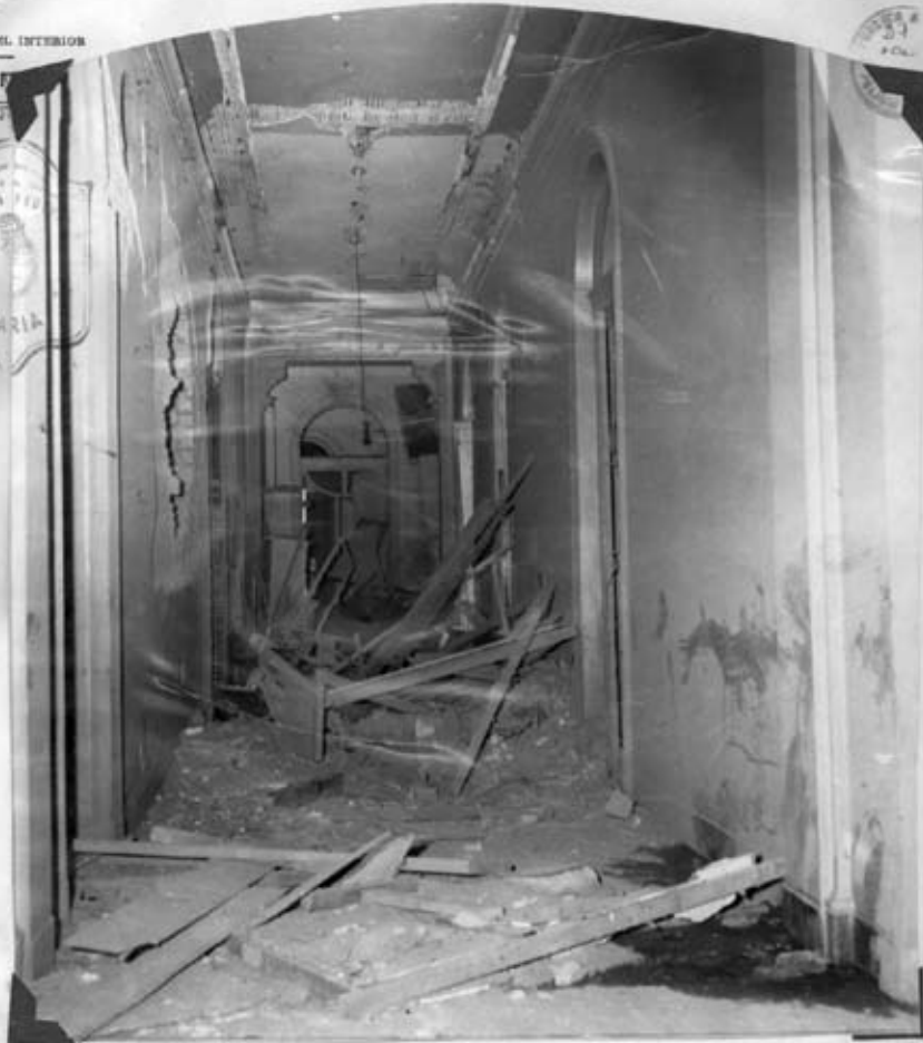
PASILLO DE LAS DEPENDENCIAS OCUPADAS POR LA DIVISION COMUNICACIONES, EN LA PLANTA BAJA.- CASA DE GOBIERNO.-
