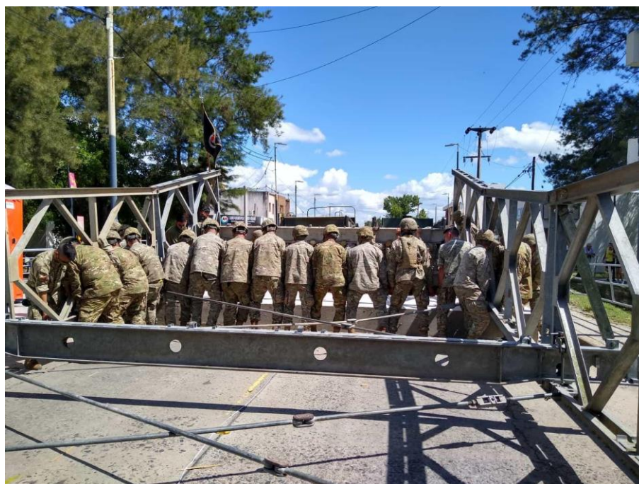
Aplicaron capacidades militares en apoyo de la comunidad – Armado de puente en localidad de Pergamino, Buenos Aires, para suplantar temporalmente un puente dañado, enero 2021 -
