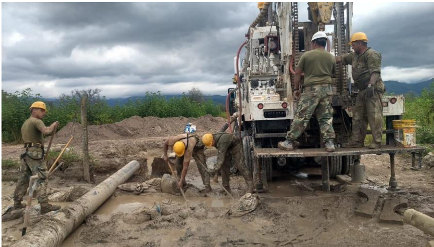
Estuvieron 7 meses perforando y reparando pozos de agua en Salta. – Operadores del equipo de perforación de la Compañía de Ingenieros de Agua 601 comprueban salida de agua de la perforación en reparación, junio 2020 -
