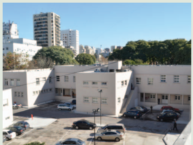
Vista aérea del edificio anexo
