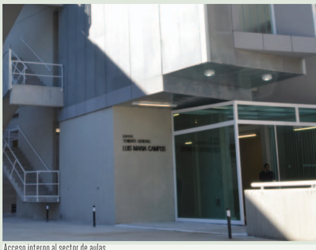
Acceso interno al sector de aulas
