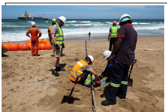
Instalación de cables submarinos
