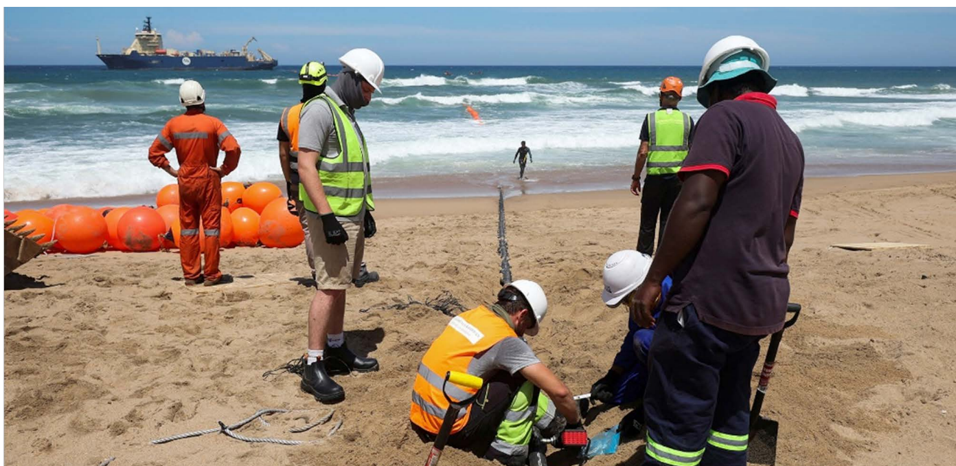
Instalación de cables submarinos
